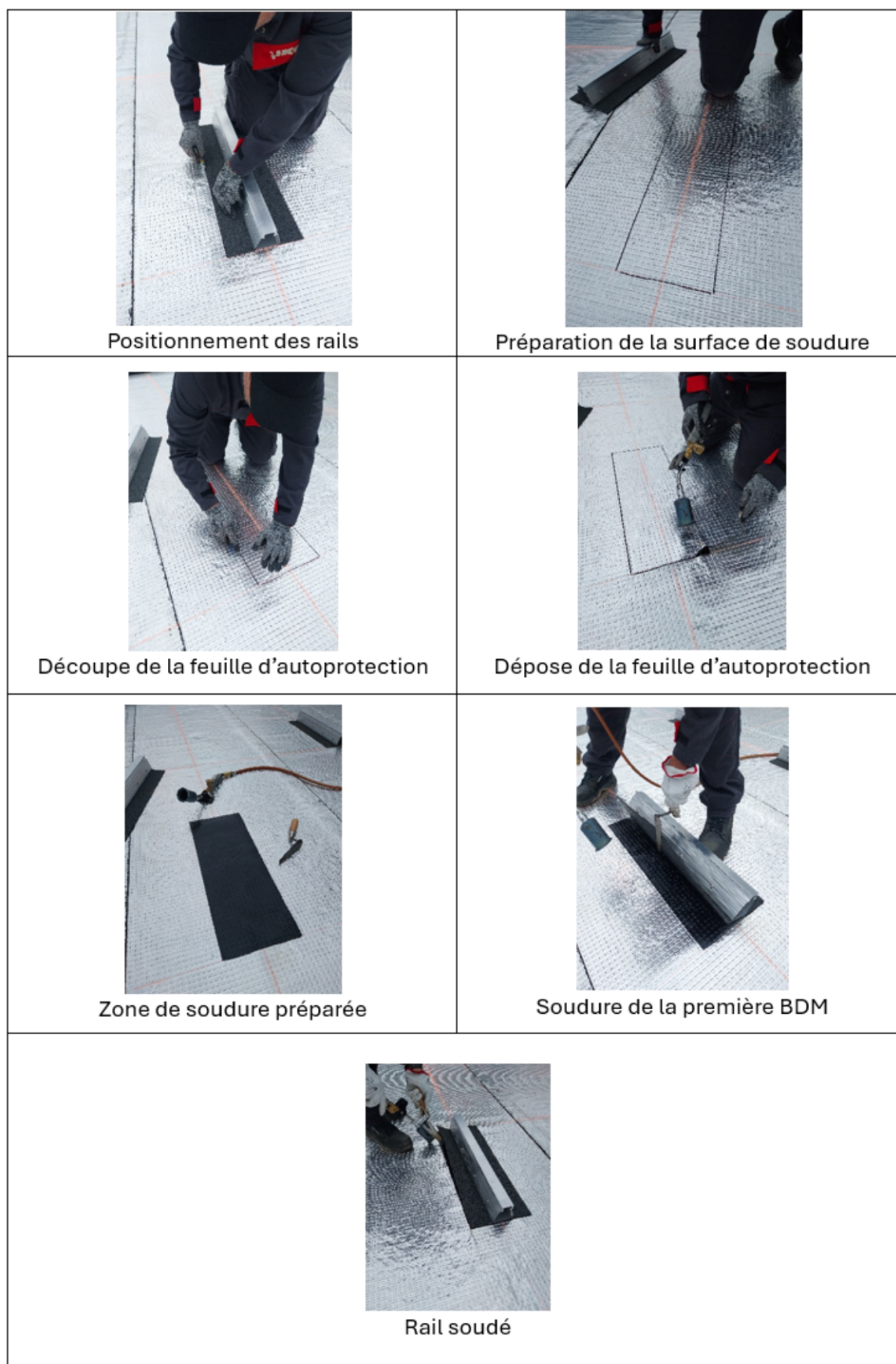
Figure 31 - Soudure d'un rail avec seconde couche IKO DUO SOLAR ALU/F ou IKO DUO FUSION ALU/F (aluminium)
