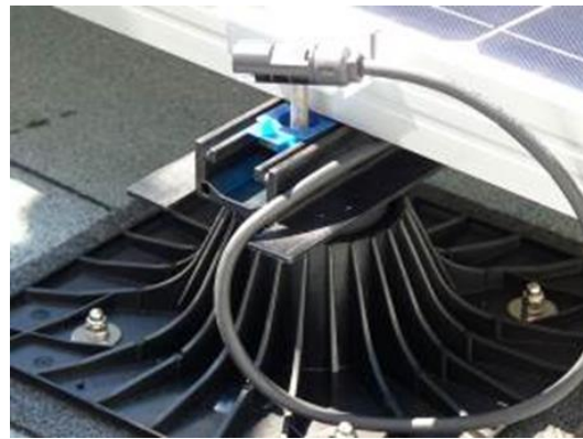
Figure 21 : Orientation de la tête du plot pour la pose du module photovoltaïque
