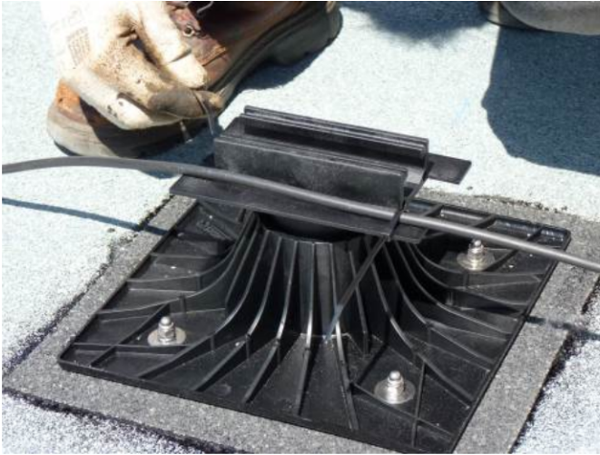
Figure 24 : Fixation câble électrique sur le plot standard à l'aide de collier Rislant et plot SOPRASOLAR FIX EVO -6- à l'aide d'un accessoire qui se fixe dans l'encoche de l'ailette
