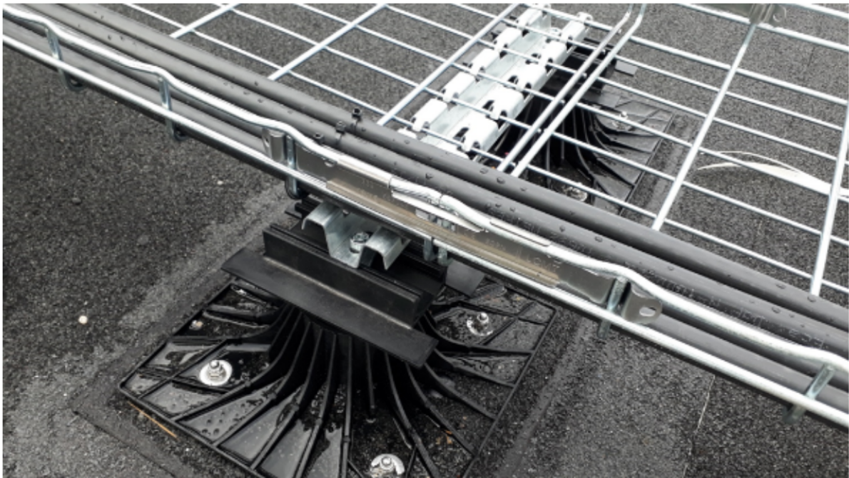
Figure 21 : Plots FIX EVO supports de chemin de câble
