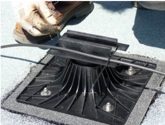
Figure 27 : Fixation câble électrique sur le plot standard à l'aide de collier Rislan et plot SOPRASOLAR FIX EVO -6- à l'aide d'un accessoire qui se fixe dans l'encoche de l'ailette
