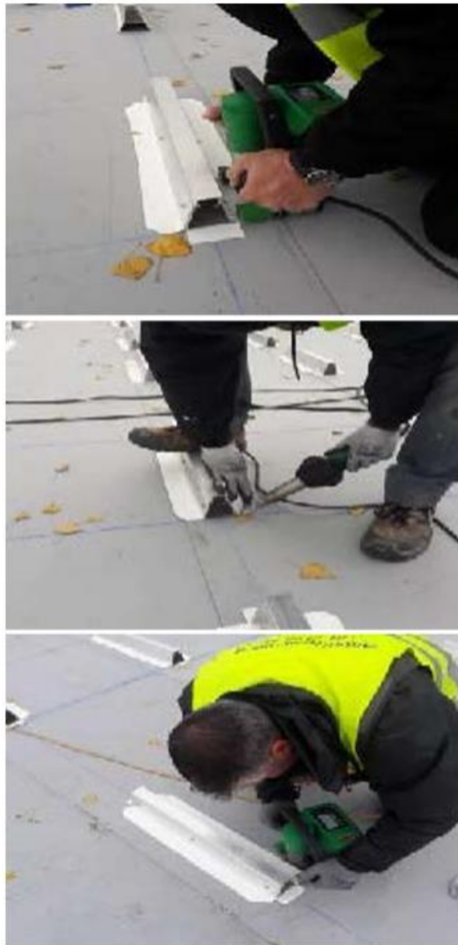
Figure 33 - Soudure sur toute la largeur de la bande de maintien d'un ensemble « Rail »
