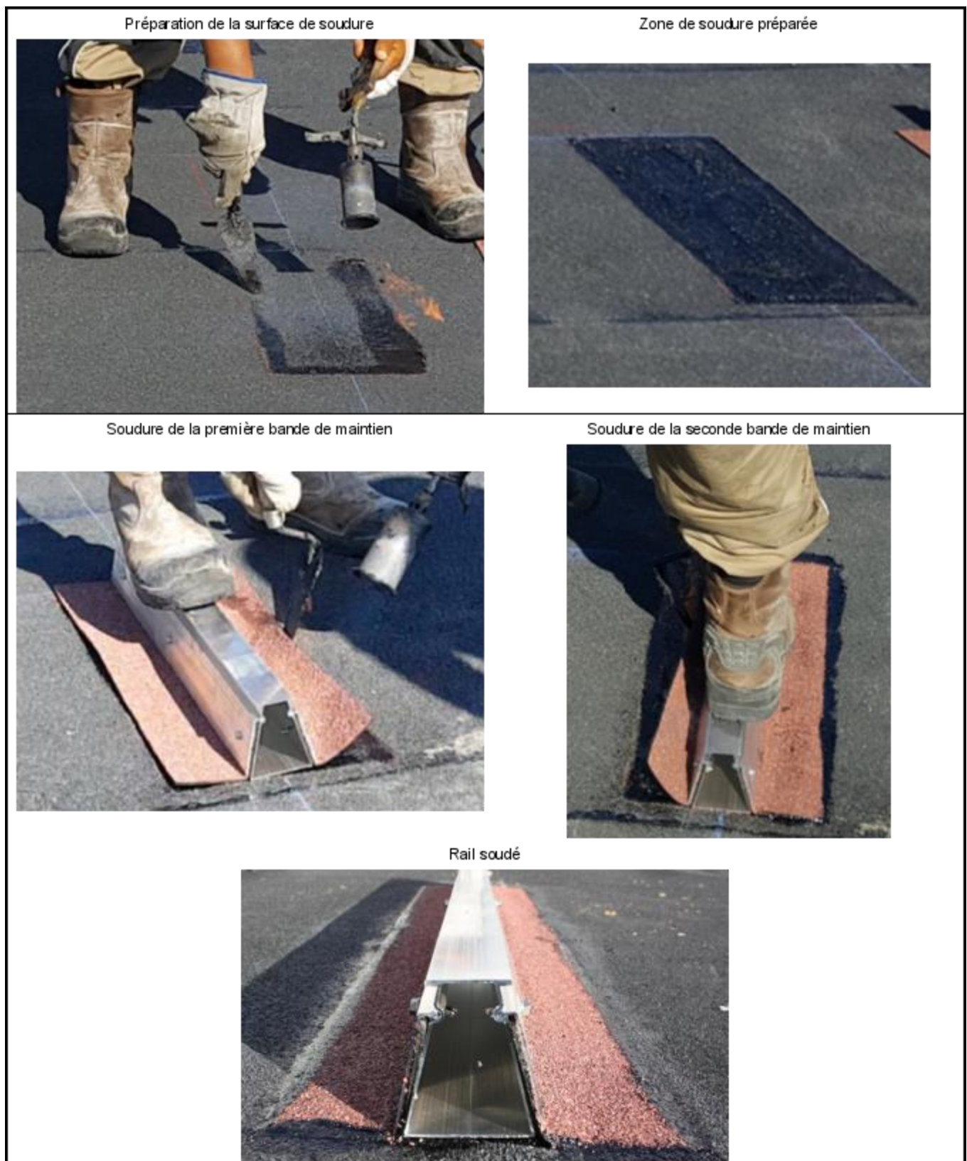
Figure 30 - Soudure d'un rail
